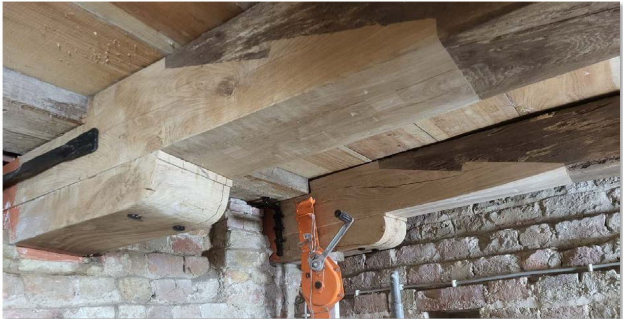
Herstelwerkzaamheden van draagbalken in de toren van Bitgum.
