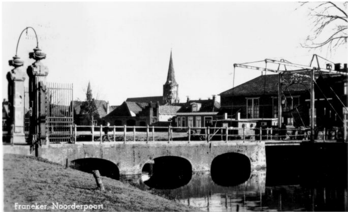
De Noorderpoort met vaste- en ophaalbrug en natuursteen pijlers met hekwerk. (de natuursteen pijlers en hekwerk, bij ons in eigendom, staan nu op het bolwerk)
